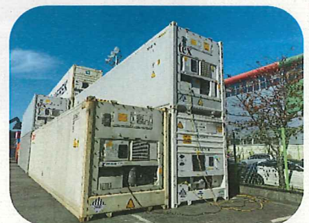
リーファーコンテナプラグ 10基 設置
